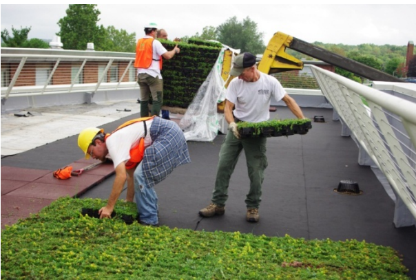
Figure 9.6 Mise en œuvre des bacs HYDROPACK®
