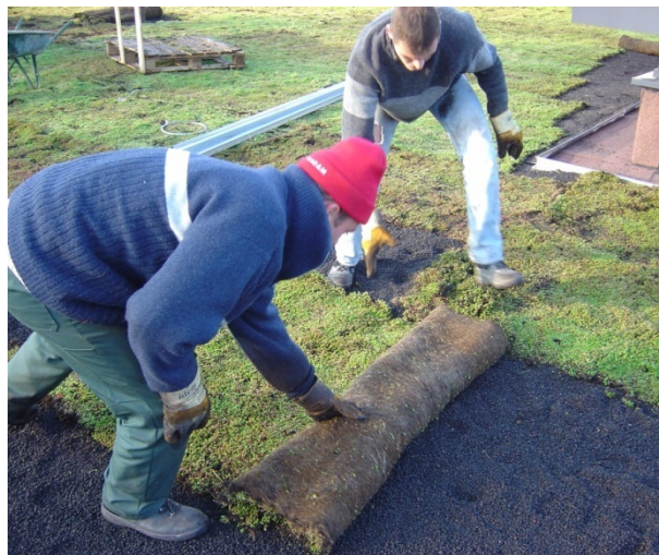
Figure 9.11 Mise en œuvre de la couche végétale par tapis i.D. MAT SEDUM
