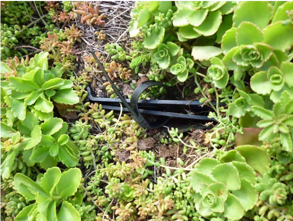
Figure 9.4 HYDROPACK® : illustration du mode de liaisonnement des bacs entre eux par collier
