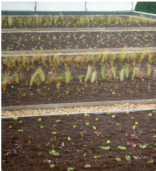
Figure 9.10 Mise en œuvre de la couche végétale par plantation de micromottes (couvert i.D. MIXFLORE PRAIRIE)
