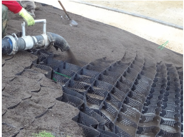
Figure 9.9 Mise en œuvre de la couche de substrat en big bags, puis nivellement - pente comprise entre 21 et 35 %
