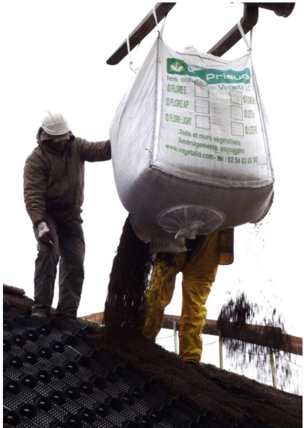
Figure 9.9 Mise en œuvre de la couche de substrat en big bags, puis nivellement - pente comprise entre 21 et 35 %
