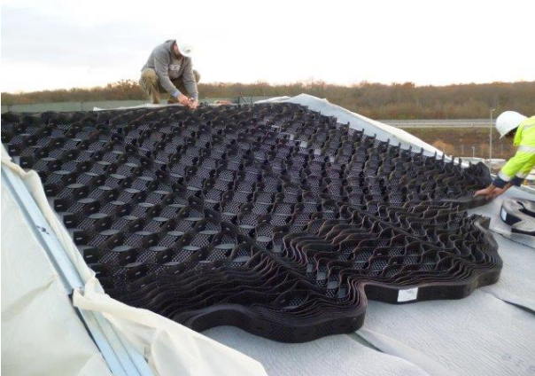
Figure 9.6 Mise en œuvre des bacs HYDROPACK®
