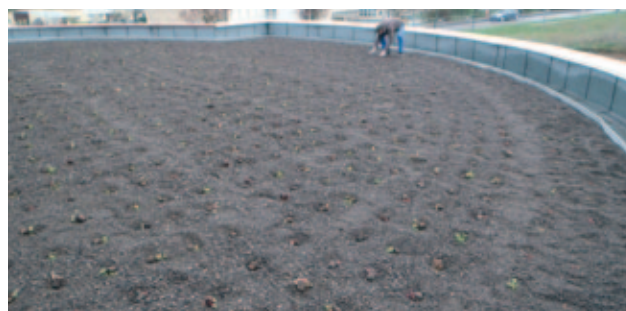
Mise en oeuvre i.D. MOTTE
